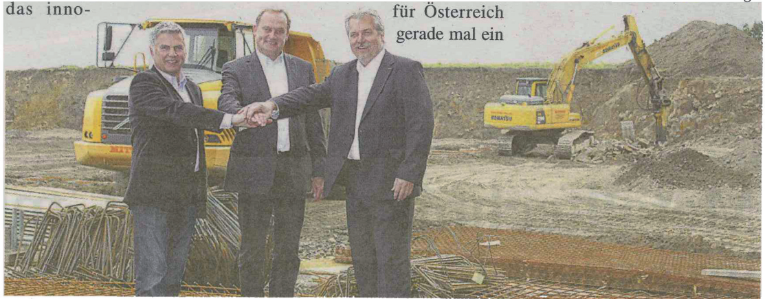
Bgm. Josef Moser, Obmann Wolfgang Schirz und WK-Bezirksstellenobmann Herbert Mairhofer (v. l.) bei der Baustellenbesichtigung von Viscotec in St. Martin
