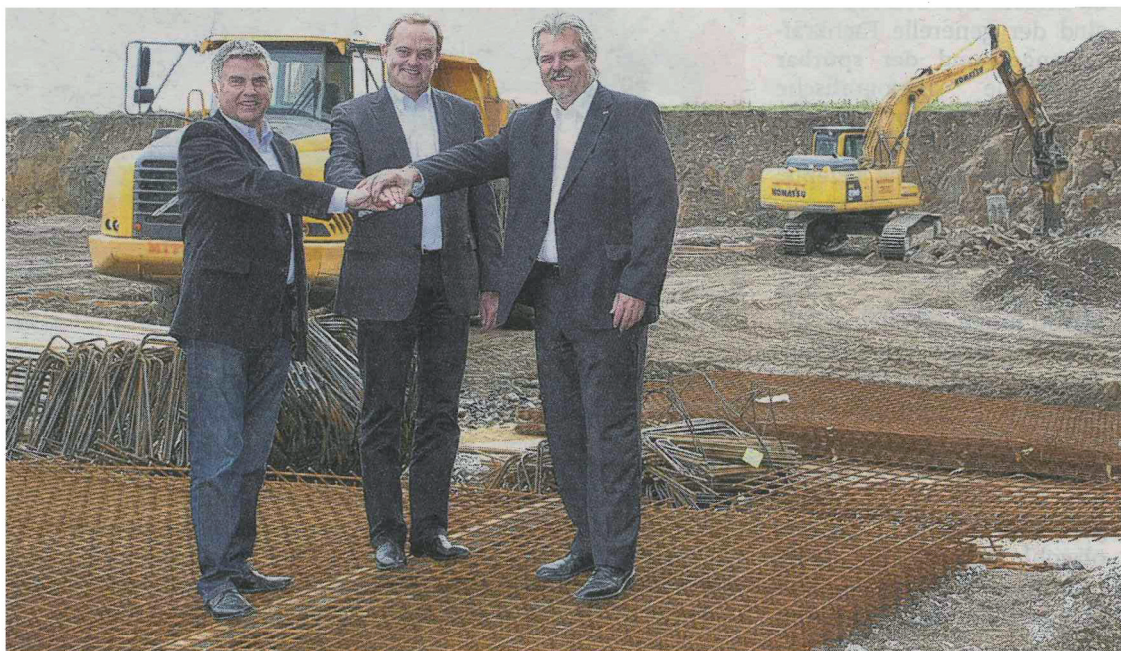
Bürgermeister Josef Moser , Bgm. Wolfgang Schirz und Obmann Wirtschaftspark Oberes Mühlviertel sowie Herbert Mairhofer, WKO-Bezirksstellenobmann (v. l.) auf der Baustelle der Firma viscotec. Foto: Privat
